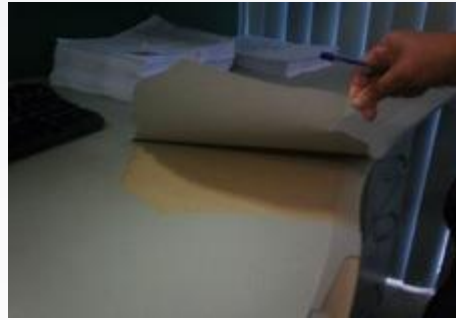
Forro de escritorio desprendido.
