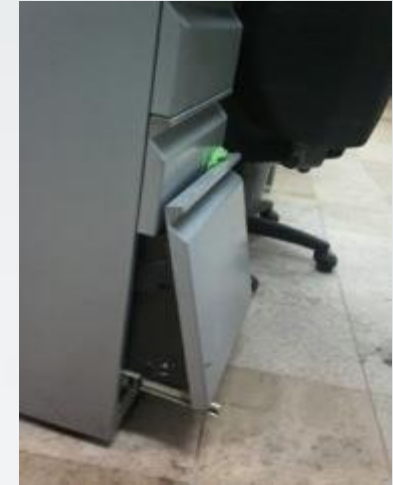
Cajonera de archivo no cierra por daño, el riel se desvio.
