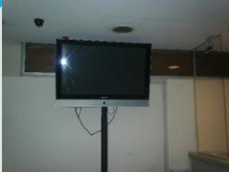
Lámpara descompuesta y cableado sin acomodar.
