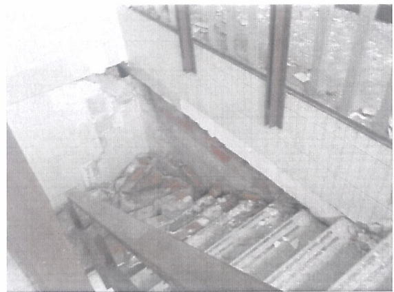
Cubo escaleras: desprendimiento de acabado.
