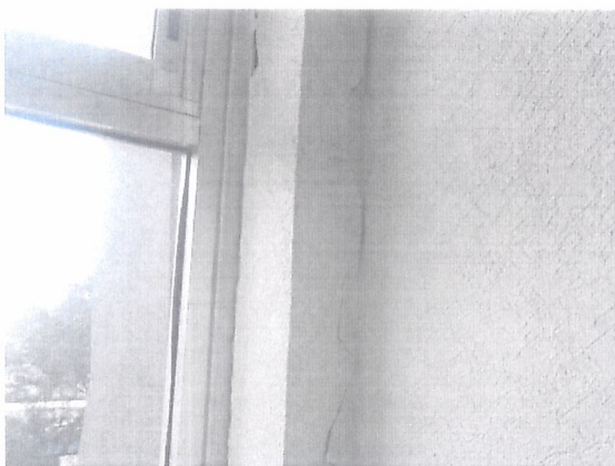
Fisura en acabado de pasta.
