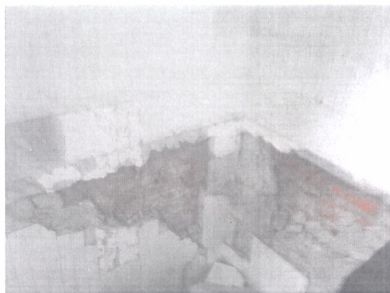
Cubo escalera: desprendimiento de acabados.
