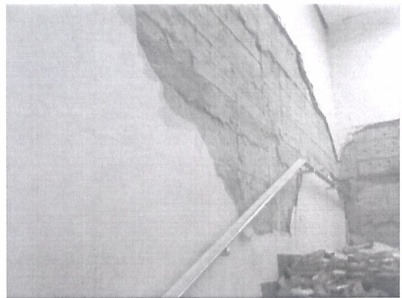
Cubo escaleras: desprendimiento de acabado.
