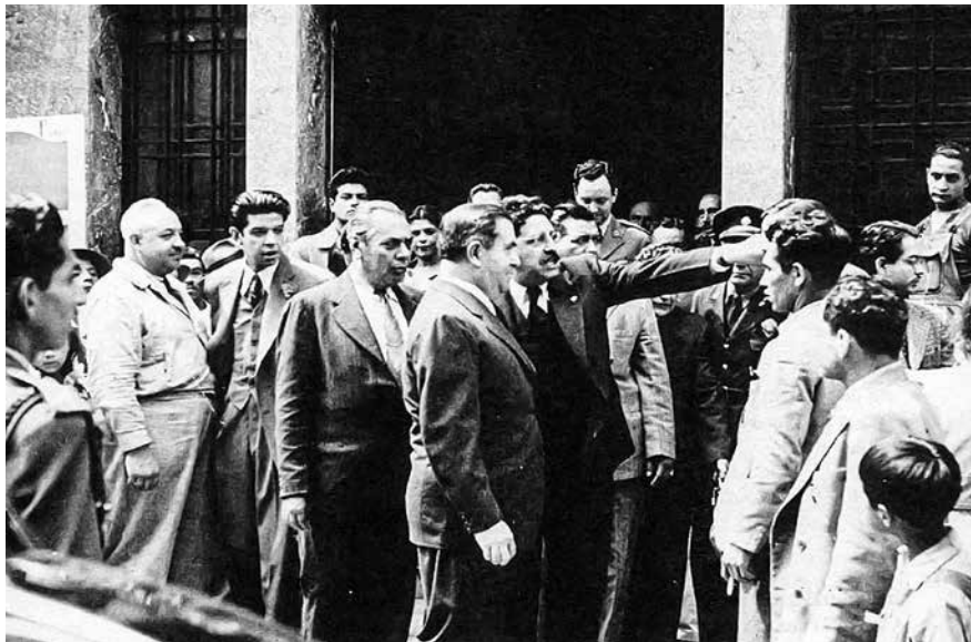
■ Ignacio García Téllez comenta al Presidente Manuel Ávila Camacho sobre la construcción de instalaciones del Instituto.
