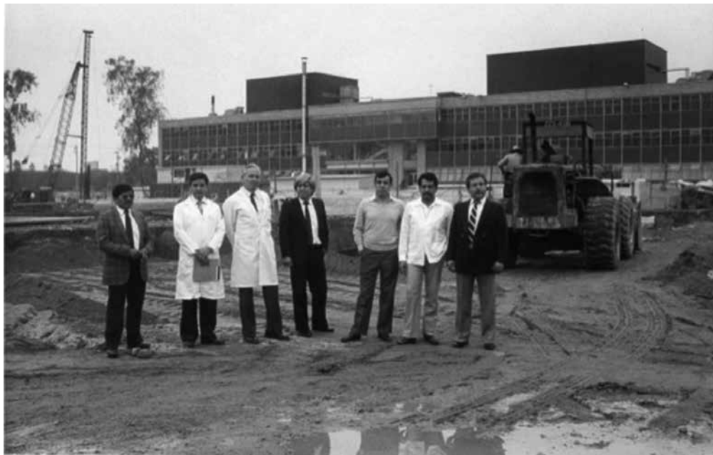
Figura 2. El doctor A. Zárata en la reconstrucción del CMN Siglo XXI.
