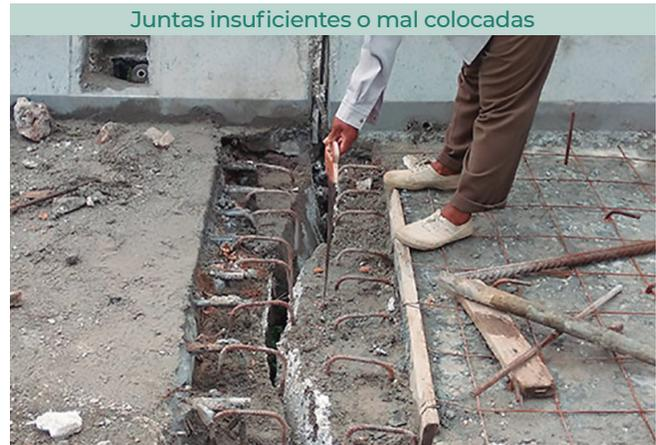
Juntas insuficientes o mal colocadas
