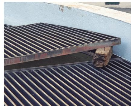
Las aberturas o desniveles que pongan en riesgo al personal de sufrir accidentes de trabajo se deberán proteger mediante barandillas u otros sistemas de protección y seguridad, y contar con su respectiva señalización.
