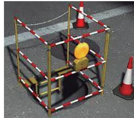
Las aberturas en el piso que puedan propiciar una caída se protegerán mediante barandales u otros sistemas de protección de seguridad equivalente.
