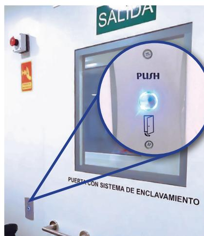
Los dispositivos de enclavamiento deben seleccionarse e instalarse para reducir al mínimo la posibilidad de fallos y defectos y la protección general no debe impedir las tareas de producción.
